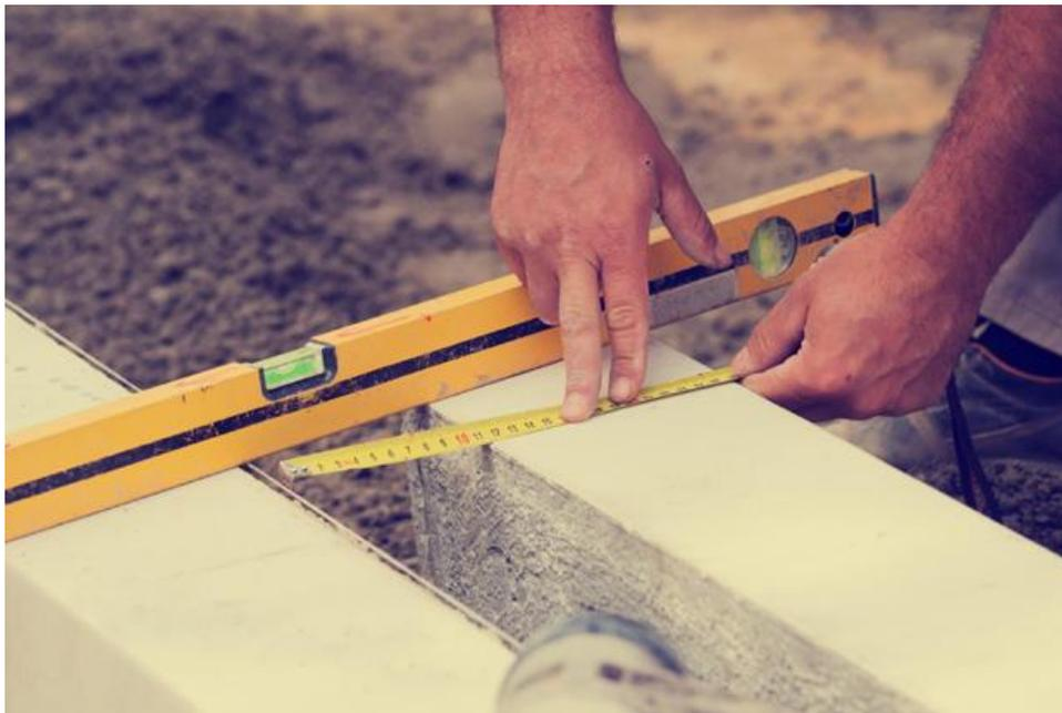
Misurata la lunghezza del muro, bisogna prestare attenzione alla larghezza del coprimuro da acquistare; se il muro da coprire è largo 20 cm, la misura interna del coprimuro deve essere di 22 cm, calcolando 2
